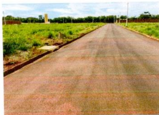
foto 04: abertura de via "reservatório"
