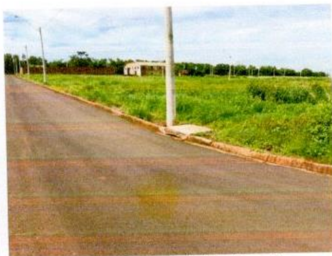
foto 02: detalhe "boca de lobo" em via
