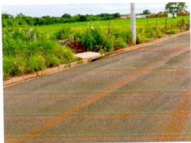
Foto 03: abertura de via "boca de lobo"
